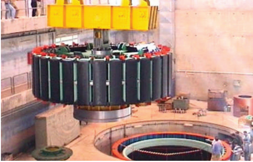
Resim 5.2 Dicle hidroelektrik santrali (HES) rotor montajı
